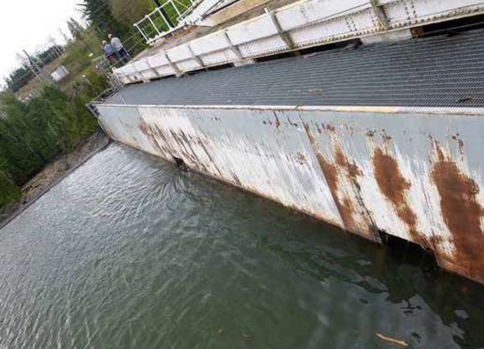
Bild till vänster: Bypass ingångarna vid ett av kraftverken i Winooski River. Under vattenytan finns ett intagsgaller som ska hindra fisk och skräp från att gå in i turbinerna. Trots gallret passerade flera fiskar via turbinerna. Dessutom överlevde flera fiskar inte bypass-passagen.
